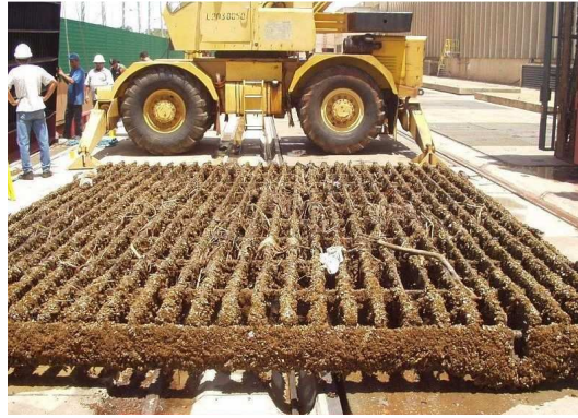
Fig. 1 - Bioincrustação na grade de tomada d'água retirada da UHE Eng. Sérgio Motta (Porto Primavera)
