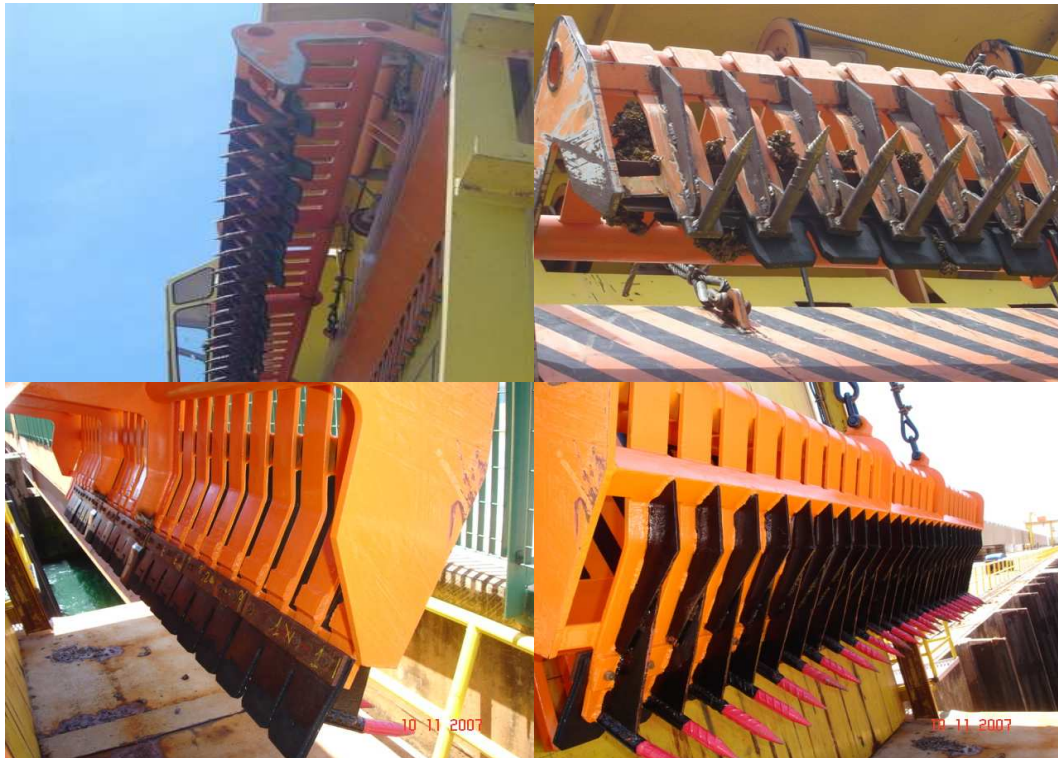
Fig. 2 – Modificações no limpa grades da UHE Eng. Sérgio Motta (Porto Primavera)
