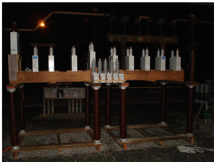
Figura 6 – Unidades capacitivas conectadas ao barramento de neutro
