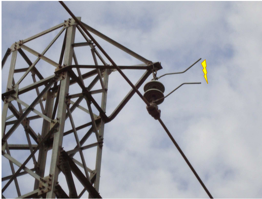
Figura 2 – Foto de um dos centelhadores internos à subestação inversora
