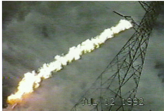
Figura 2. Falla a tierra en 230 kV
