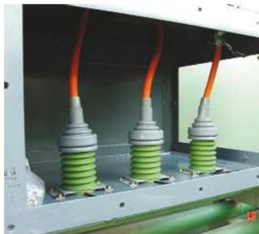
Figura 5 - Capacitor de acoplamiento [imagen extraída de internet, s.f.-]
