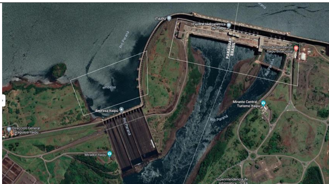
Figura 5: Linhas 500kV sobre o Rio Paraná e o Lago
