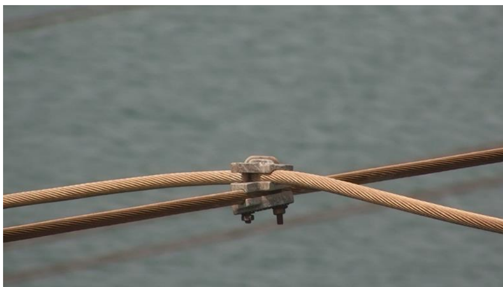
Figura 7 – Parafusos de conectores com aperto desproporcional
