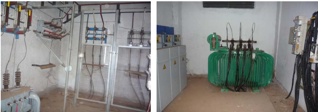
*Figura 3* – Puestos de Distribución Subterráneos a) Tablero con Seccionadores de MT Bajo Carga y Tablero BT independiente b) Con Celdas Compactas
