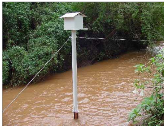
FIGURA 2: abrigo para instalação de sensores.
