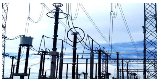
Figura 2: TPC-OTCF/550 kV de Línea (fase T) Figura 3: Placa Sup. del TPC-OTCF/550 kV
