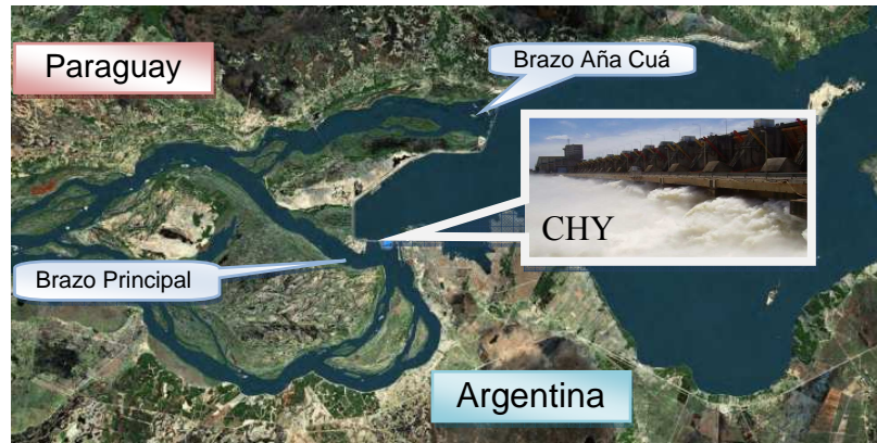
Figura 1. Ubicación de la Central Hidroeléctrica de Yacyretá [7]
