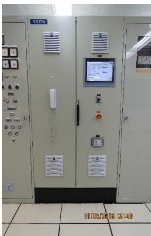
Figura 1. Nuevo tablero VGC.
