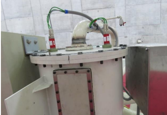
Figura 10. Transductor lineal de posición de álabes del rodete.
