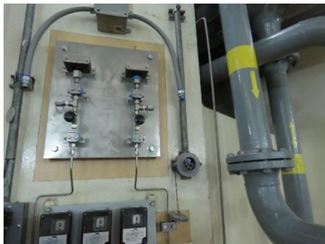
Figura 12. Transductor de presión de “abrir/cerrar” de servomotores.
