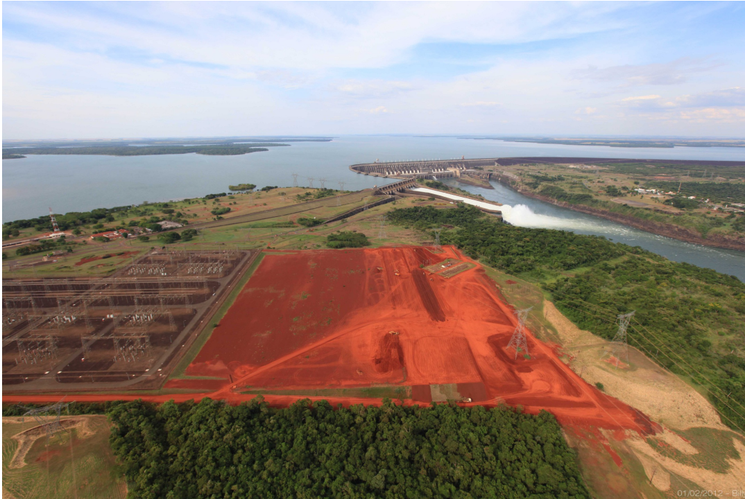
FIGURA 2 : Vista Aérea del Patio para el Seccionamiento de las LTs
