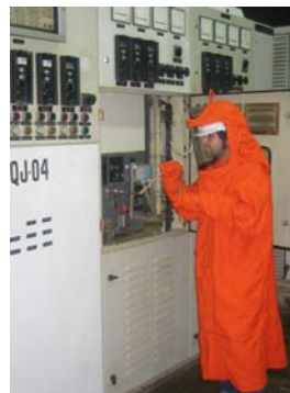
Fig 19 y 20 Personal técnico introduciendo el interruptor durante el mantenimiento de los mismos
