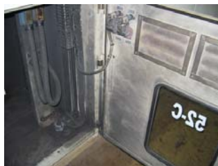
Fig. 3 Conductores quemados
