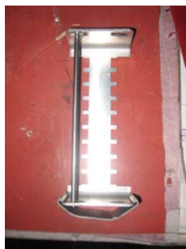
Figuras 16 y 17 Vista del anteparo de plástico colocados a todos los interruptores de modo a evitar la caída del pasador
