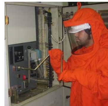
Fig 19 y 20 Personal técnico introduciendo el interruptor durante el mantenimiento de los mismos
