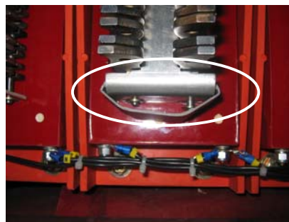
Figuras 16 y 17 Vista del anteparo de plástico colocados a todos los interruptores de modo a evitar la caída del pasador
