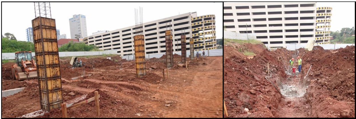
Figura 2. Predio de la Subestación Microcentro en etapa de construcción civil.
