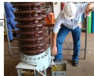
**Figura 13: Bridas y caja de bornera Secundaria antes desmontar.****Figura 14: Después de desmontar****Figura 15: Parte de drenaje de aceite**
