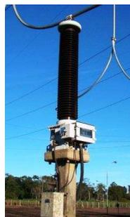
**Figura 2: Dispositivo Capacitivo de Potencial**
