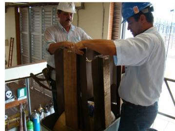
**Figura 12: Aislante separador y sujetador entre carcasa y bob. Sec.**
