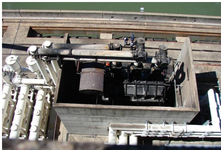
Imagen 1 – Vista superior área afectada
