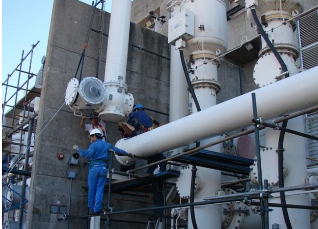
Imágenes 9 y 10 – Montaje tramo vertical y barrera de gas, ambos fase T
