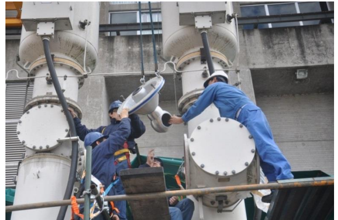
Imágenes 9 y 10 – Montaje tramo vertical y barrera de gas, ambos fase T
