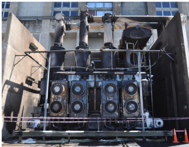
Imágenes 2 y 3 – Vista exterior transformador principal y daños en pantalla equipotencial, fase S
