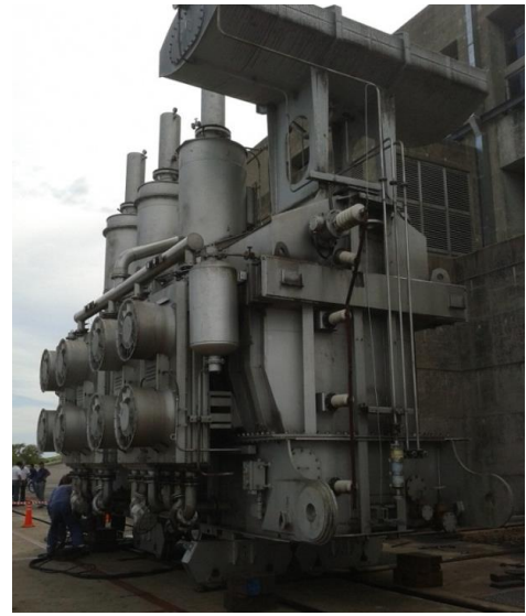
Imágenes 6 y 7 – Retiro transformador siniestrado y traslado de trafo de reserva
