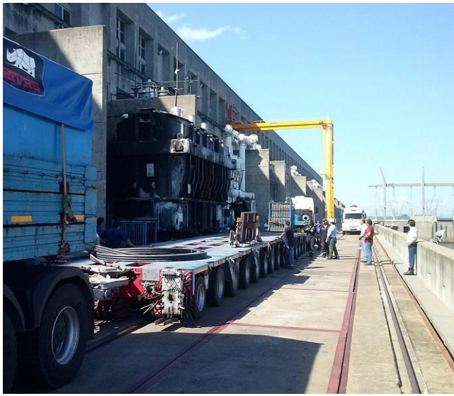
Imágenes 6 y 7 – Retiro transformador siniestrado y traslado de trafo de reserva
