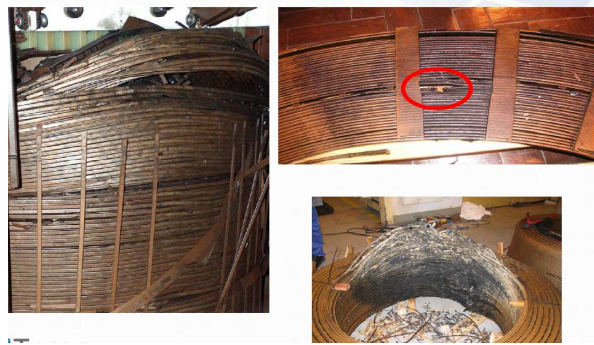
Figura 1: Falla por azufre corrosivo [2]
