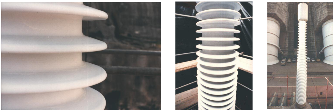
FIGURA 5 – Aparência final das buchas de 500 kV após a aplicação do RTV em 1988
