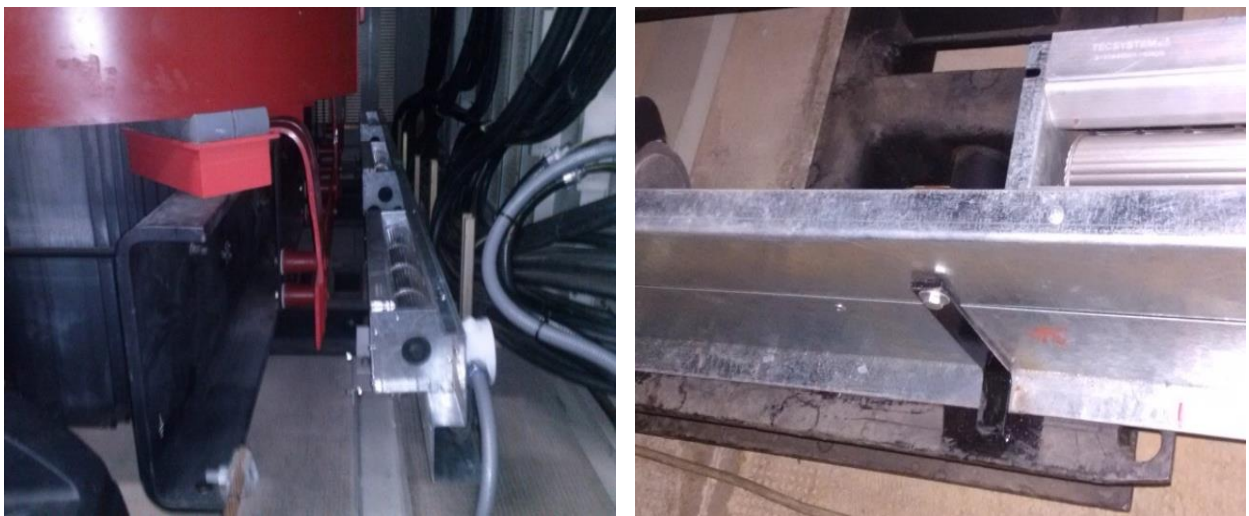
Figura 5. Montaje de las barras del Kit de Ventilación.
