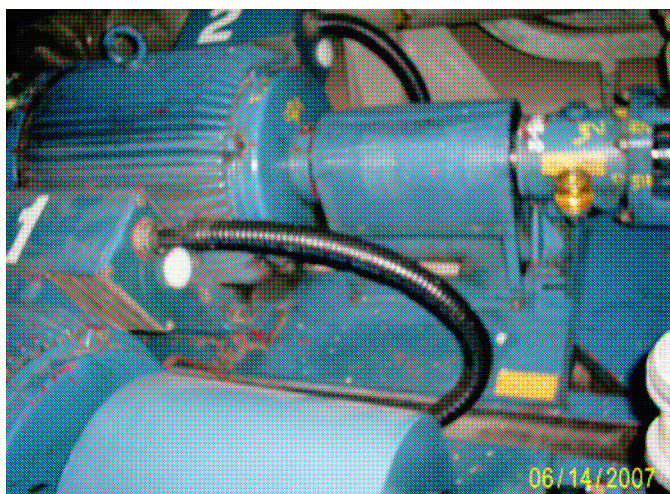
Figura 15 – Condutores para Alimentação dos Motores
