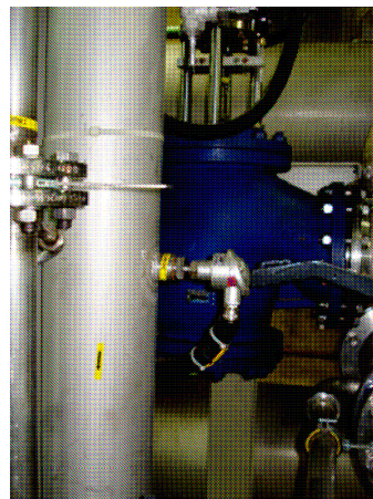
Figura 11 – Instrumentos de Temperatura (modernizados)
