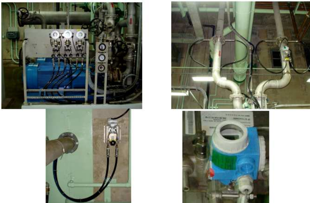
Figura 8 – Instrumentos de Fluxo e Pressão (modernizados)
