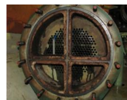
Fig. 17 – Instalación de cupones en los TC's
