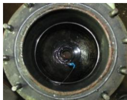
Fig. 16 – Instalación de cupones en el FH
