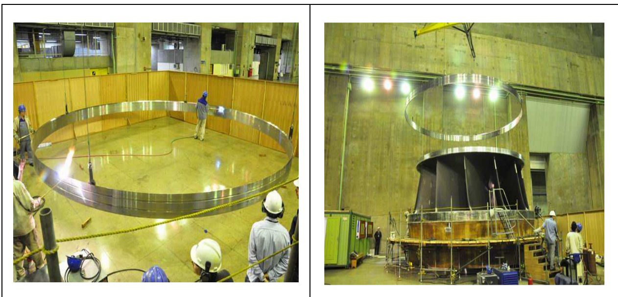
Fig.6 a) Pre calentamiento del anillo de desgaste b) Transporte del anillo a la temperatura establecida
