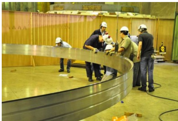
Figura 1 – Retirada do Anel de Desgaste da maquina 06.
