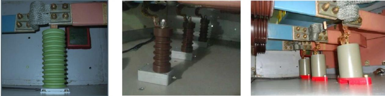
**Figura 7: Diversos capacitores de acoplamiento; 80 pF [4]; 220 pF [5]; 500 pF [6].**
