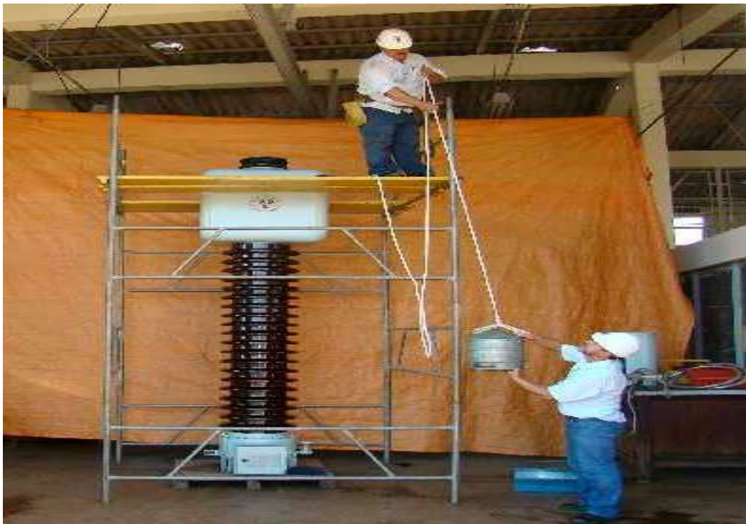
Figura 4 – Içamento do balde de 20 litros
