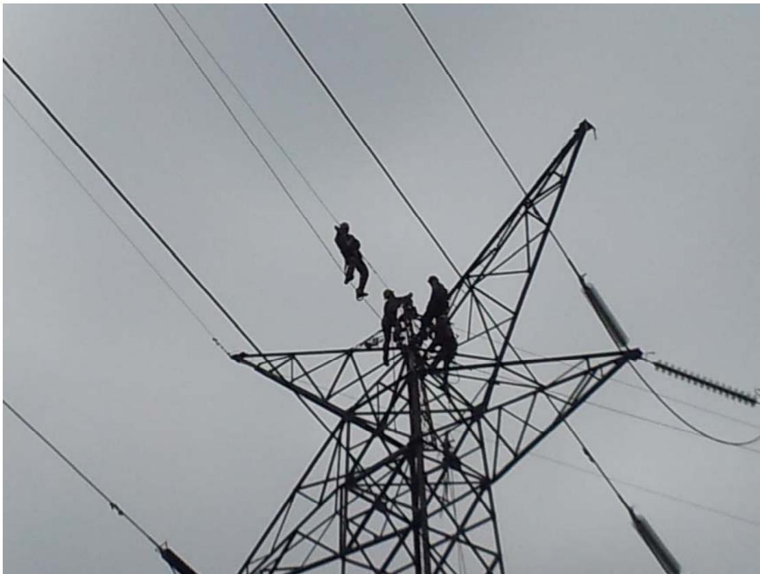
Montaje LT 500KV SEMD – Villa Hayes
